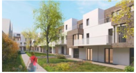
WOHNHAUSANLAGE SELLINGERGASSE, WIEN
